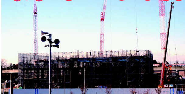
3階を建てつつ4階の柱も作っている新東葛病院 (2014年12月5日撮影)
