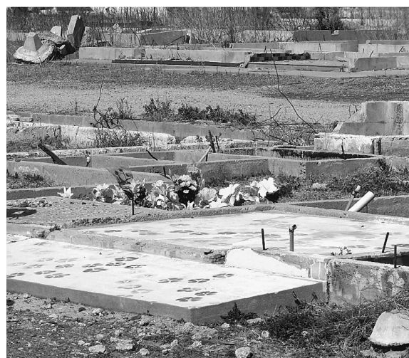
津波によって家屋が流され土台だけ残っている (いわき市豊間)。花の絵が土台にプリントされている。(2013年3月撮影)
